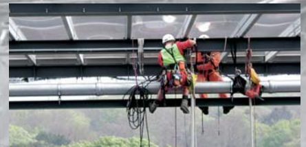
RheinEnergieStadion Köln Kabelverlegearbeiten, Montage von 200 Lautsprechern und Scheinwerfern
