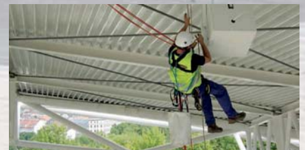
Zentralstadion Leipzig Montage-, Kontroll- und Nacharbeiten im gesamten Dachbereich der Tribünen
