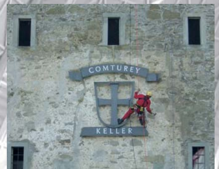
Comturey Keller, Insel Mainau Wildwuchsentfernung, Gefahrstellen- beseitigung, Mauerwerksicherung und Fugenausbesserung.
